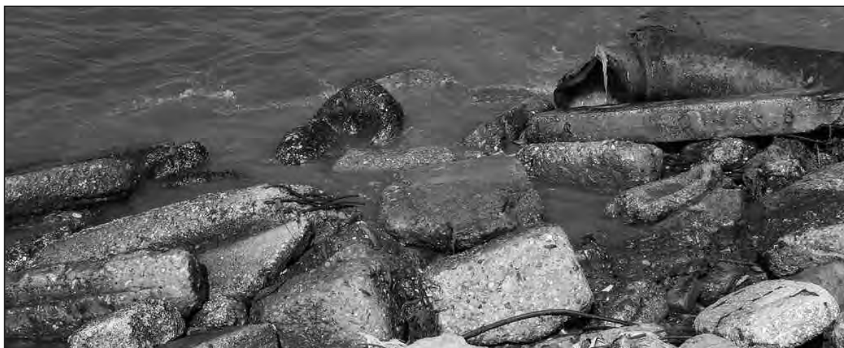
À Gaza, les eaux usées s'écoulent dans la mer, contaminant l'aquifère côtier (photo UNRWA/Khalil Adwan).
